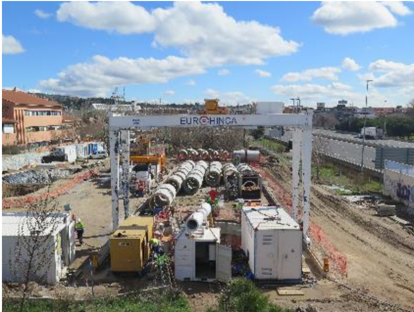
Pórtico grúa sobre pozo de hinca
