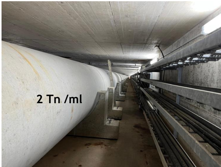
Zona de galería / Tubo de hormigón
